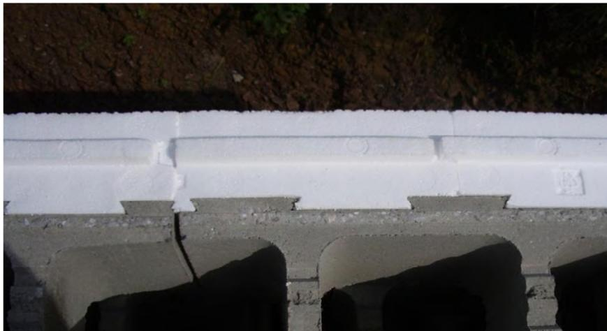
Le positionnement des alvéoles du Bloc Global Construct garantit une dispersion optimale du béton lors du remplissage.
