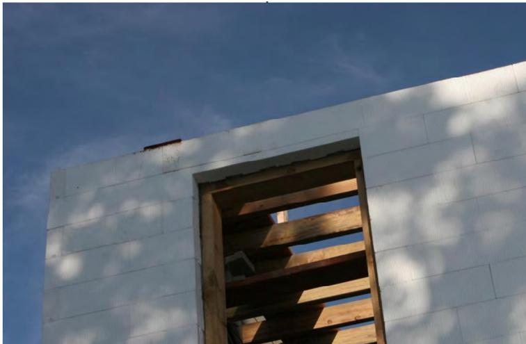
Un coffrage simple suffit à finir les ouvertures et linteaux
