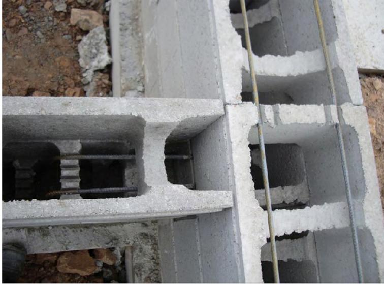
Armatures sur certaines portions des murs. Ceinture avant hourdis, liaisons des murs intérieurs, normes antisismiques....
