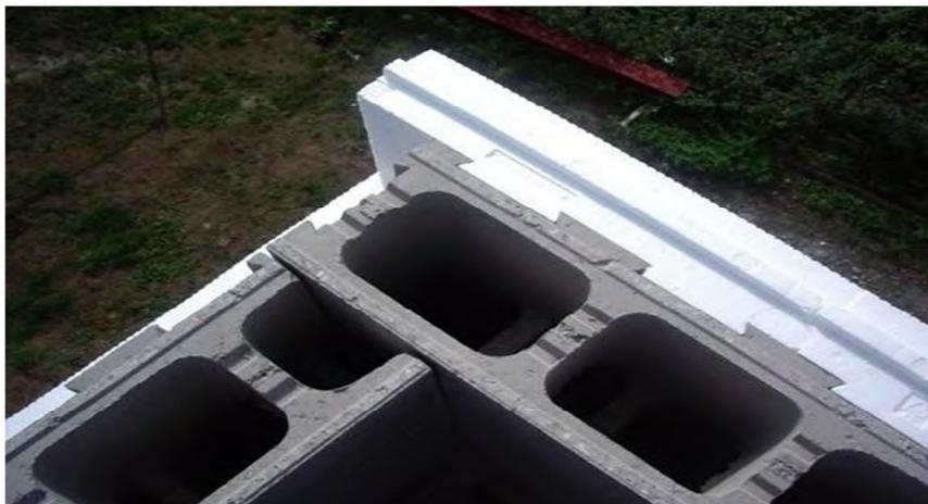
Le pas des fixations permet d'assembler les composants de manière ininterrompue au fur et à mesure de l'élévation du mur.
