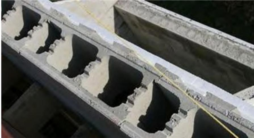
Uniquement deux références (un bloc de coffrage et un bloc isolant) suffisent à la réalisation de la plupart des modules de la construction.
